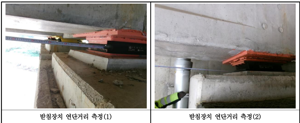
【사진 21.3.39】 교량받침장치 연단거리측정
