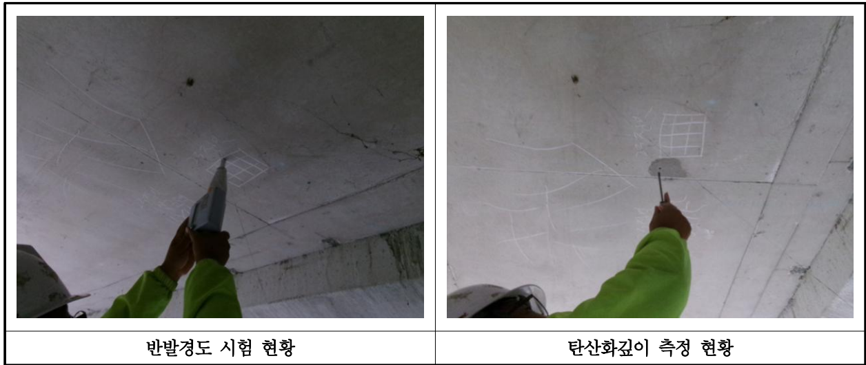
【사진 21.4.1】 콘크리트 내구성조사 현황
