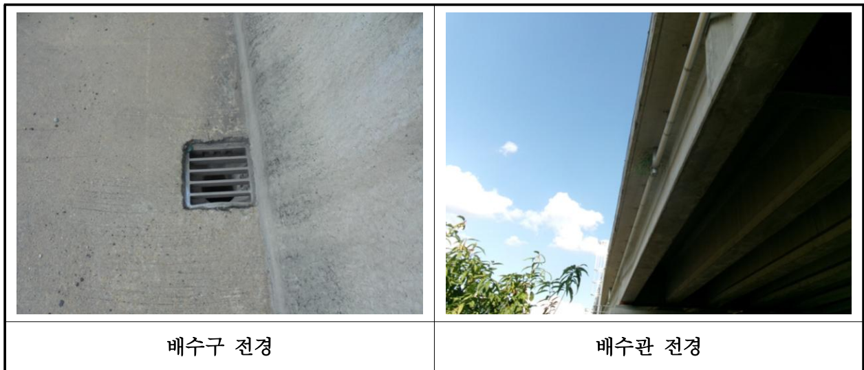
【사진 21.3.21】 배수시설 전경
