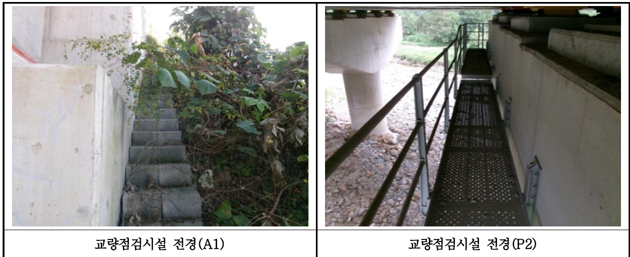
【사진 21.3.25】 교량 점검시설 전경
