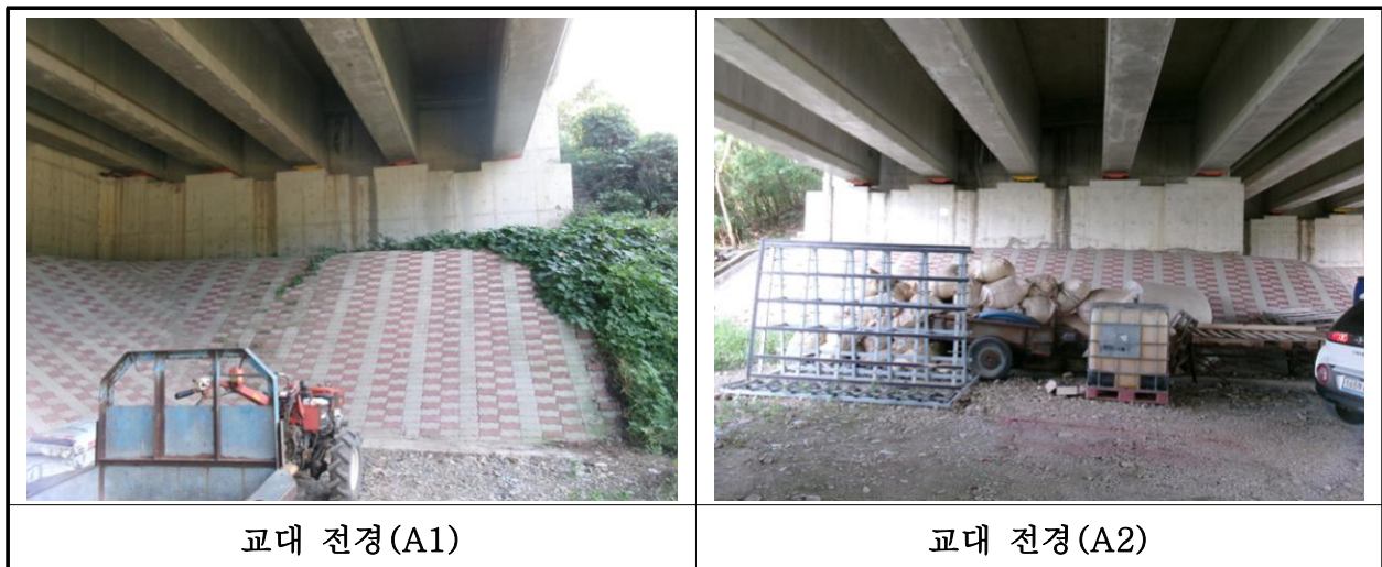
【사진 21.3.8】 교대 전경
