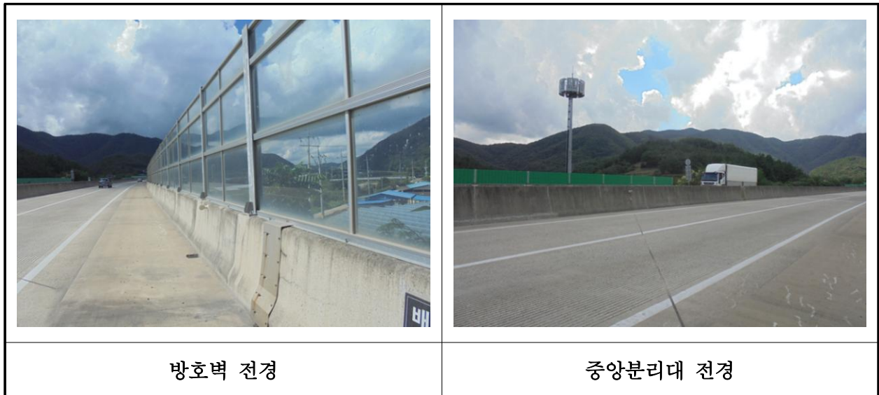
【사진 21.3.23】 방호벽 및 중양분리대 전경
