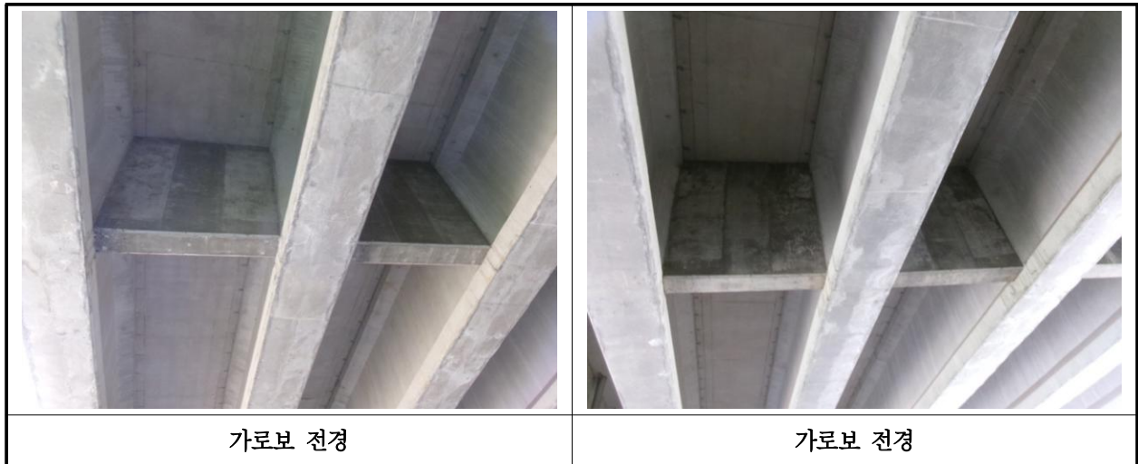
【사진 21.3.6】 가로보 전경
