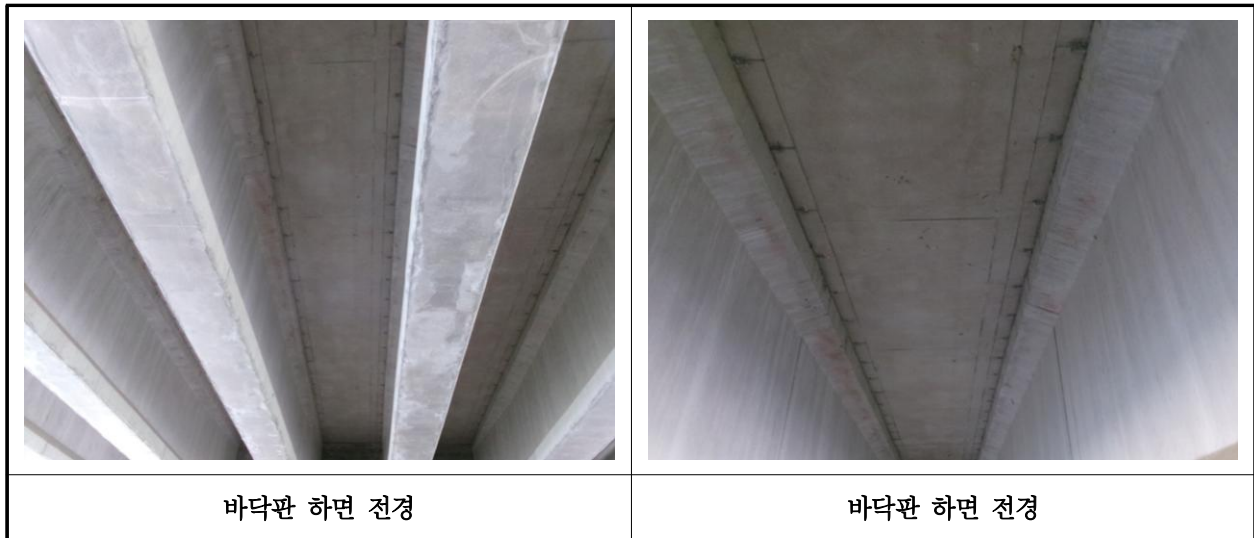
【사진 21.3.2】바닥판하면 전경
