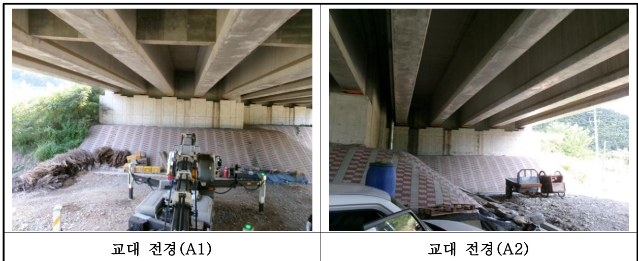
【사진 21.3.33】 교대 전경
