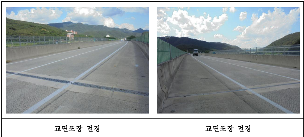
【사진 21.3.44】 교면포장 전경
