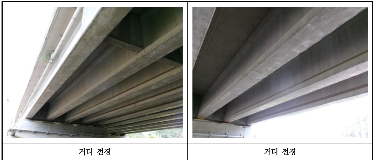
【사진 21.3.4】 거더 전경
