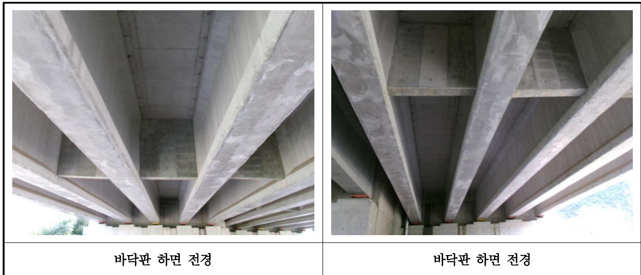
【사진 21.3.27】 바닥판하면 전경
