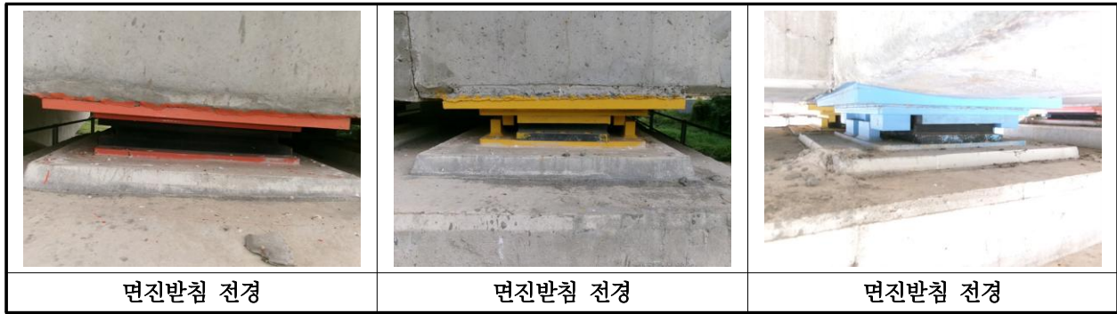
【사진 21.3.12】 교량받침 전경
