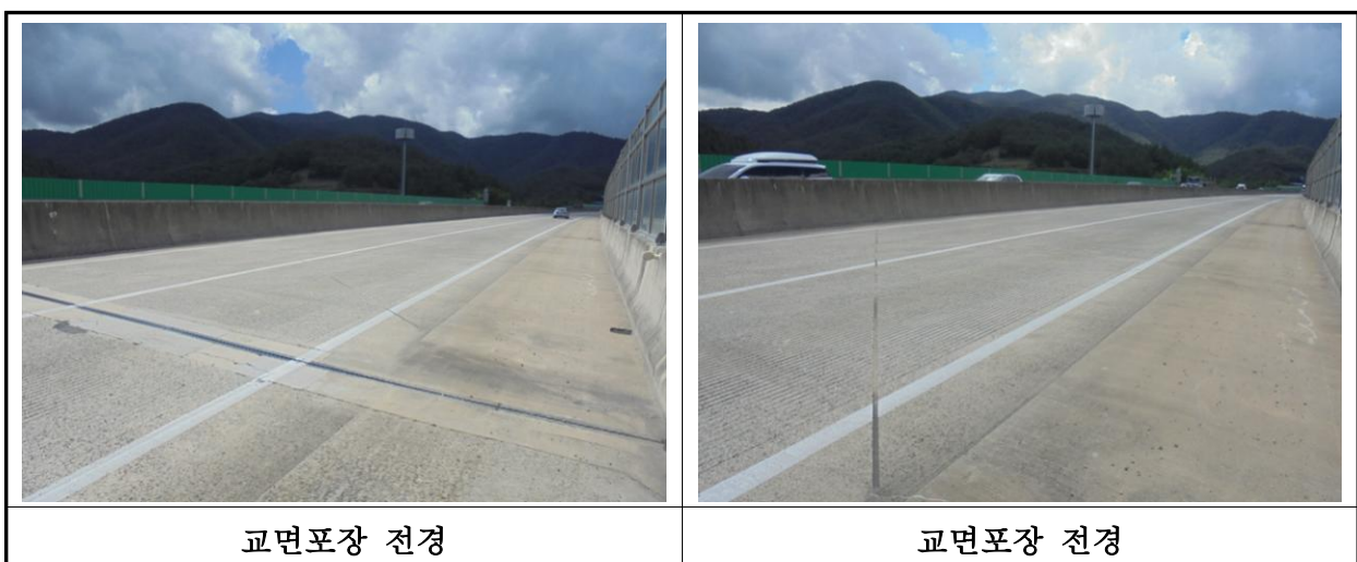
【사진 21.3.19】 교면포장 전경
